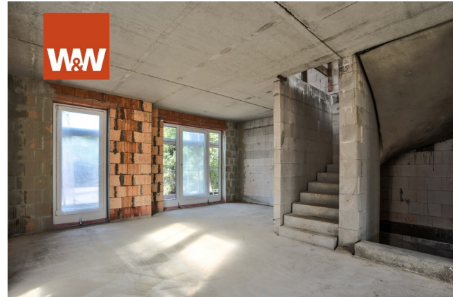
Wohnebene mit massiven Betondecken
