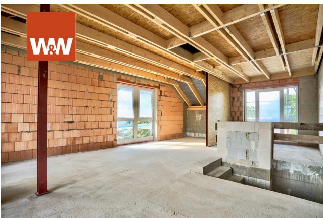
Schlafebene Bautenstand Juni 2019
