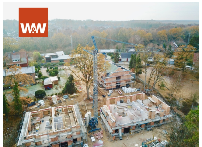
Haus 5 bis 9 - Blick Richtung Lüneburg
